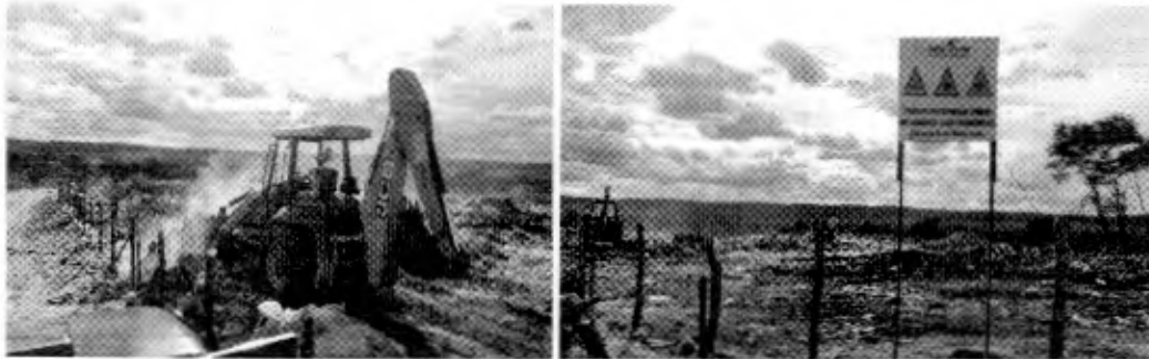
Foto 11 – Aterramento, cercamento e sinalização do lixão municipal.
