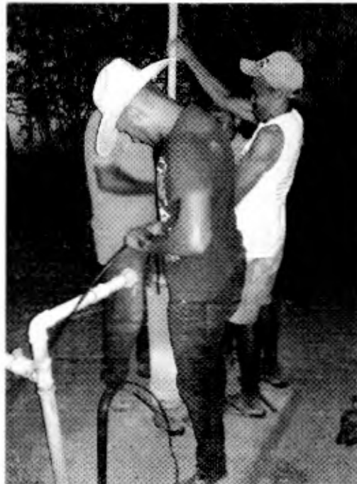
Foto 17 – Recuperação do Poço Artesiano do Povoado Cacimba Nova
