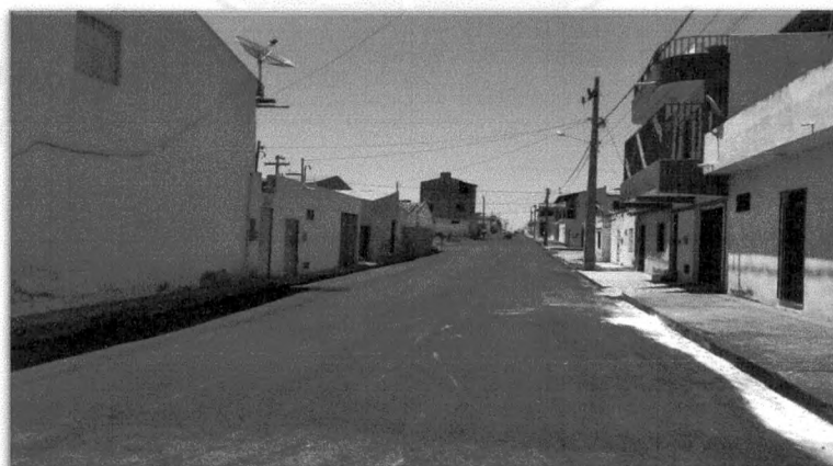
Foto 36: Pavimentação Asfáltica na Antônio de Santana Neto Fonte acervo próprio – 2018
