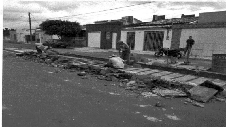
Foto 12: Reconstrução da cobertura do canal da rede de esgoto na Rua Paulo Santos Fonte acervo próprio – 2018
