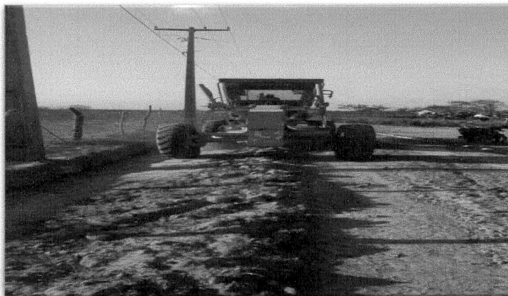
Foto 05: Recuperação de estradas vicinais do Povoado Lagoa do Junco Fonte acervo próprio – 2018
