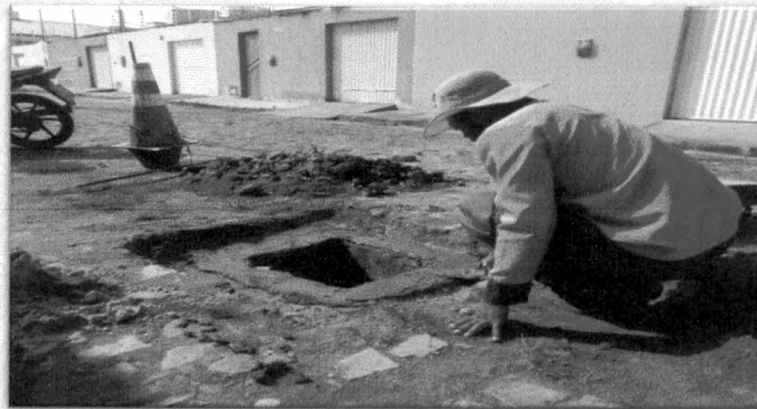
Foto 11: Construção de caixa de rede de esgoto Fonte acervo próprio – 2018
