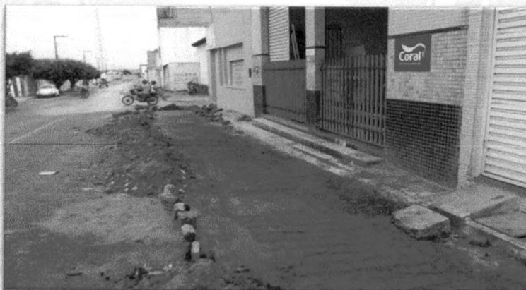
Foto 17: Reconstrução de rede de esgoto na rua Antônio Dórea Fonte acervo próprio – 2018
