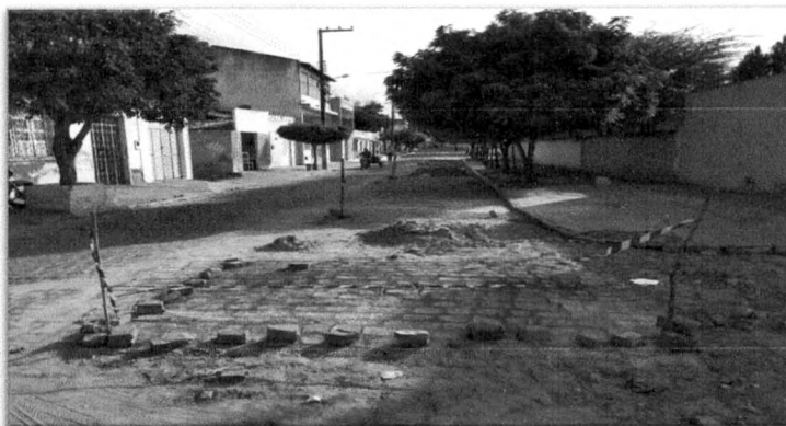
Foto 23: Recuperação á paralelepípedo na Rua Gabriel Benevides Fonte acervo próprio – 2018
