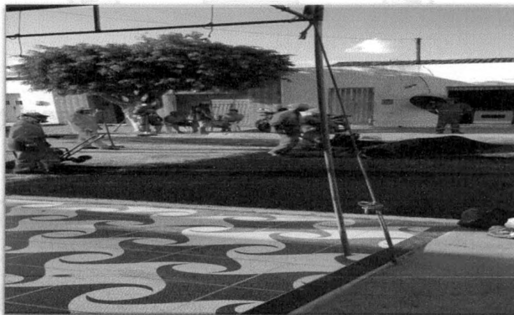
Foto 26: Recuperação Asfáltica da Avenida São José Fonte acervo próprio – 2018
