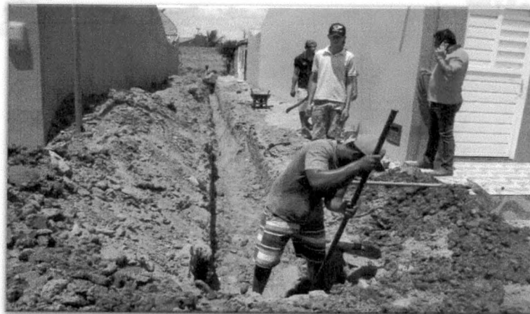
Foto 21: Construção de rede de esgoto na Rua Antônio Nascimento Silva no Bairro Fazendinha Fonte acervo próprio – 2018
