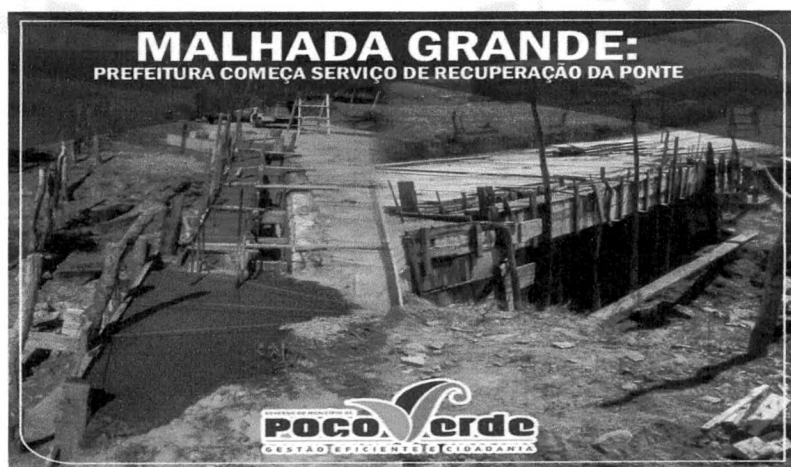
Foto 04: Reconstrução de Ponte no Povoado Malhada Grande Fonte acervo próprio – 2018
