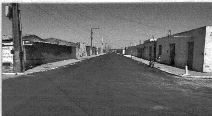
Foto 35: Pavimentação Asfáltica na Rua Joaquim Oliveira de Santana Fonte acervo próprio – 2018
