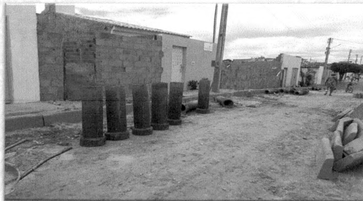
Foto 20: Construção de rede de esgoto na Rua Irmã Mariele no Bairro Santa Cruz Fonte acervo próprio –2018
