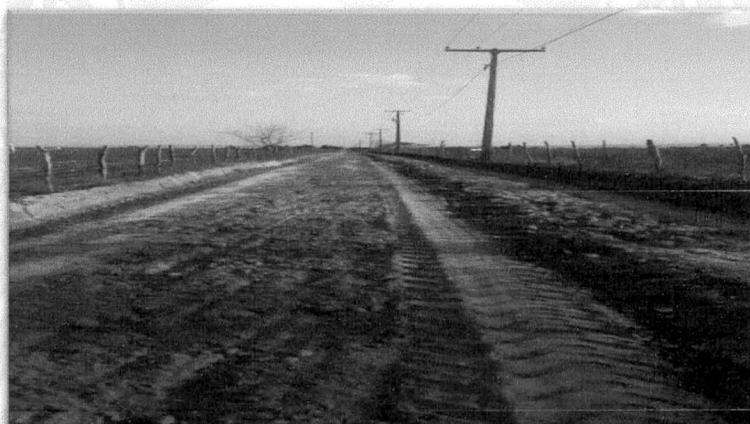
Foto 06: Recuperação de estradas vicinais do Povoado Cacimba Nova ao Povoado Cansação Fonte acervo próprio – 2018
