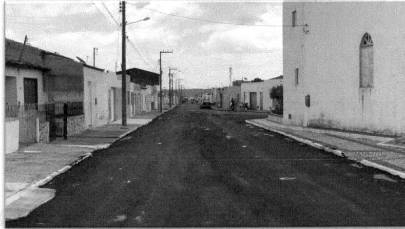
Foto 37: Pavimentação Asfáltica na Praça Antônio das Neves Celestino Fonte acervo próprio – 2018
