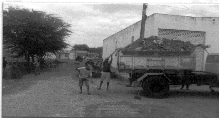
Foto 18: Limpeza do canal da rede de esgoto no fundo da Rua Mangueira Fonte acervo próprio – 2018
