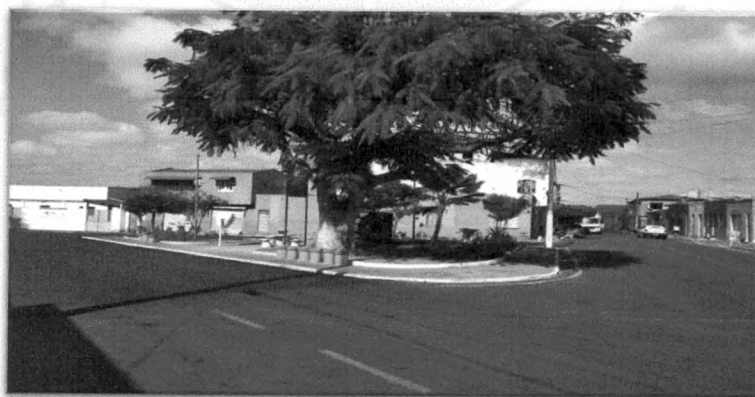
Foto 33: Pavimentação Asfáltica na Praça José Bonifácio de Souza Fonte acervo próprio – 2018
