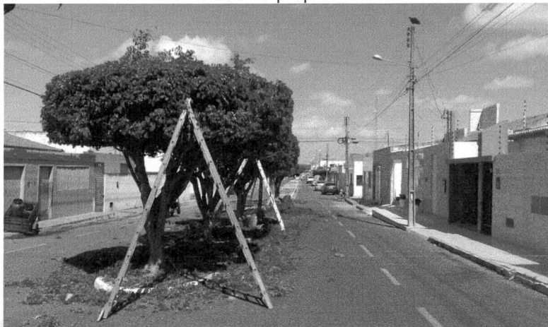
Foto 46: Serviço de poda de árvore na Rua Paulo Santos Fonte acervo próprio – 2018
