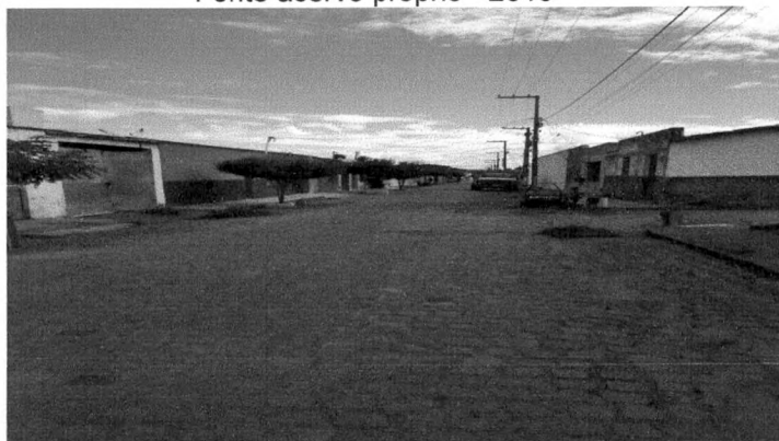
Foto 39: Capinagem na Rua Josefa Rocha Dórea Fonte acervo próprio - 2018
