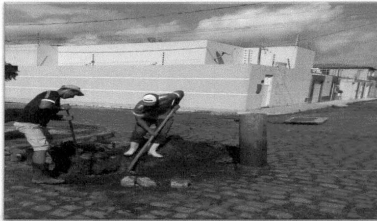
Foto 10: Limpeza na rede de esgoto no Conjunto da Caixa no Bairro Fazendinha Fonte acervo próprio –2018
