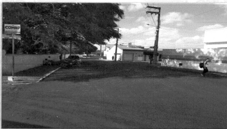
Foto 32: Pavimentação Asfáltica na Rua Gabriel Benevides Fonte acervo próprio – 2018
