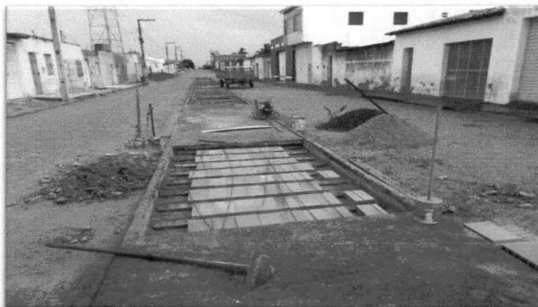
Foto 13: Reconstrução da cobertura do canal da rede de esgoto na Rua Antônio Dórea Fonte acervo próprio –2018
