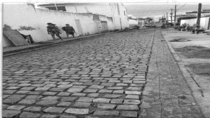
Foto 21: Serviço de recuperação á paralelepípedo na Travessa Ramalho Barreto Conceição Fonte acervo próprio –2018
