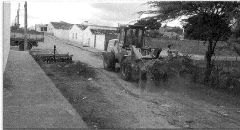
Foto 19: Limpeza do canal da rede de esgoto no fundo da Rua Mangueira Fonte acervo próprio – 2018
