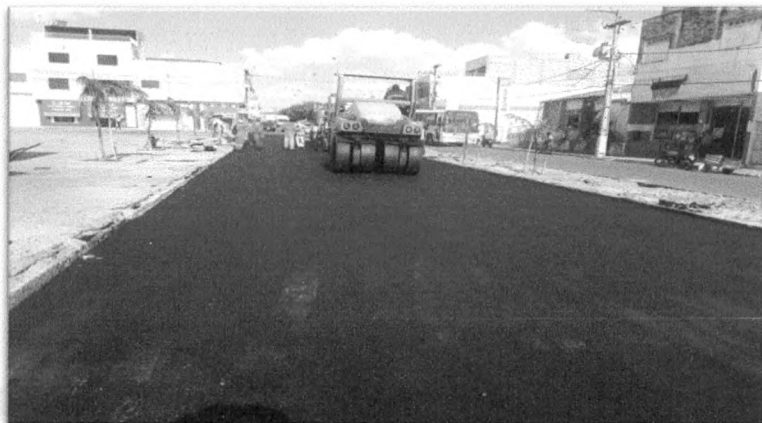
Foto 28: Pavimentação Asfáltica na Avenida Capitão José Narciso Fonte acervo próprio – 2018
