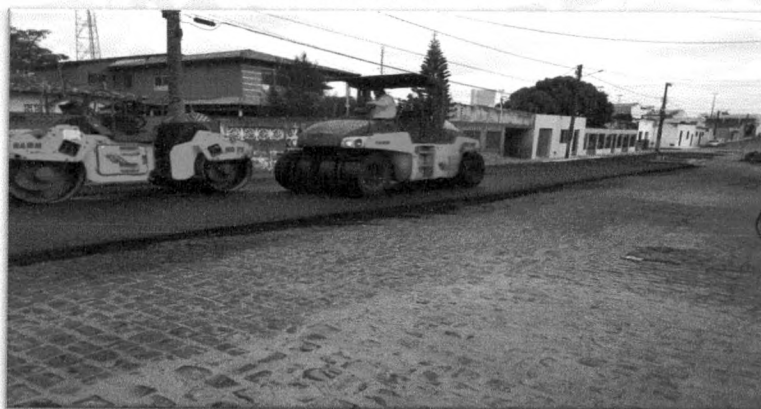
Foto 30: Pavimentação Asfáltica na Rua Eliosipio Carvalho de Andrade Fonte acervo próprio –2018
