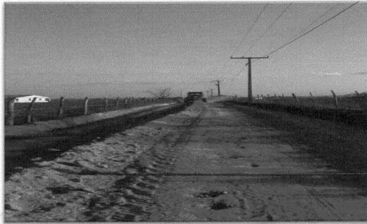
Foto 02: Recuperação de estradas vicinais da localidade Campestre Fonte acervo próprio – 2018
